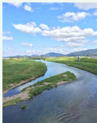
↑菊池川（熊本県） 河道掘削（ワンド造成）による 希少タナゴ等の保全
