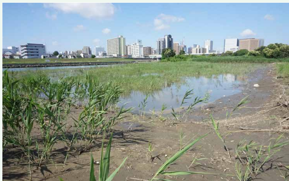
↑多摩川（六郷地区） 治水目的で河道を掘削する際に、 湿地環境を創出した例
