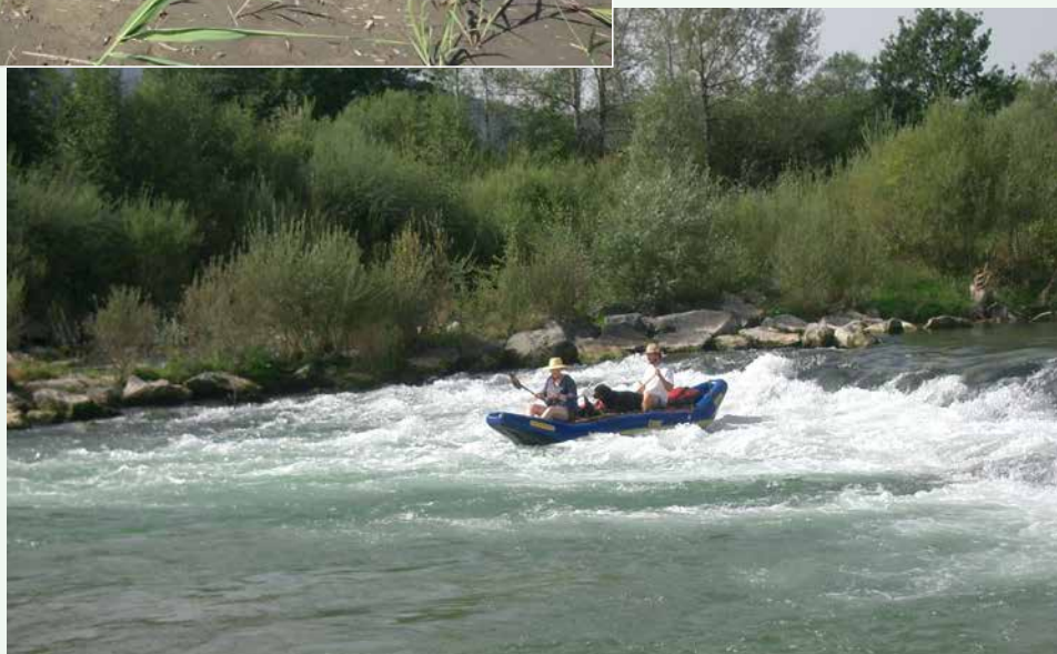
↓ロイサツハ川（ドイツ） 落差処理を石積みのランプエで行う ことにより、河床低下の抑制に加え、 魚類の移動やカヌーでの利用を可能 とした例
