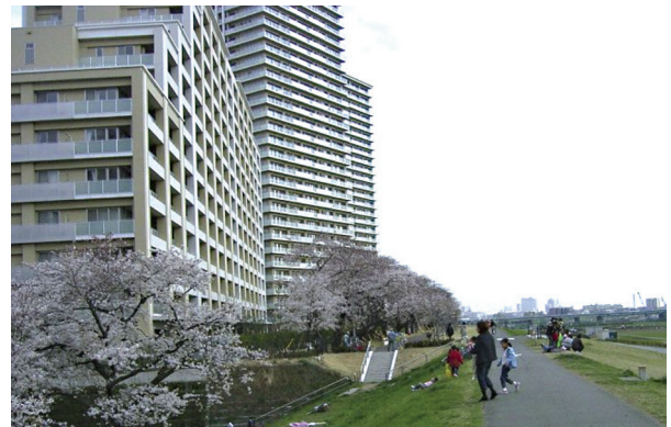
写真－1 多摩川における高規格堤防
