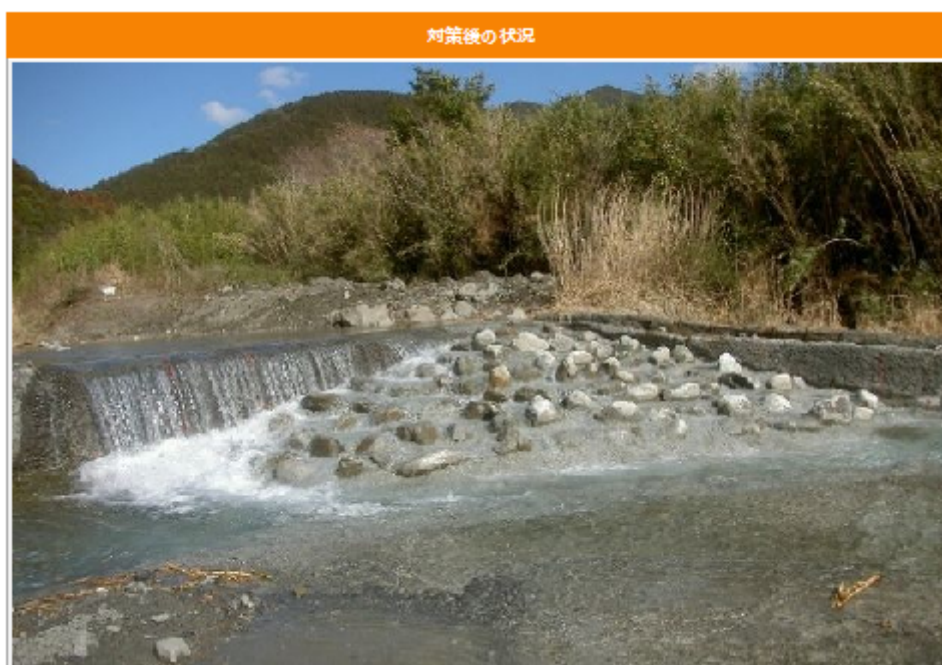
羽根川水系羽根川 高知室戸事務所の落差解消事例
