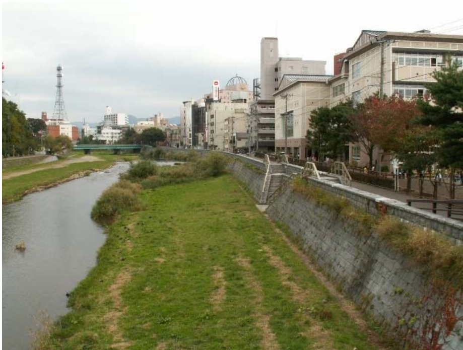
図-16 護岸前面に盛土、護岸中段の植栽により護岸の露出面積を小さくしている（中津川：岩手県）
