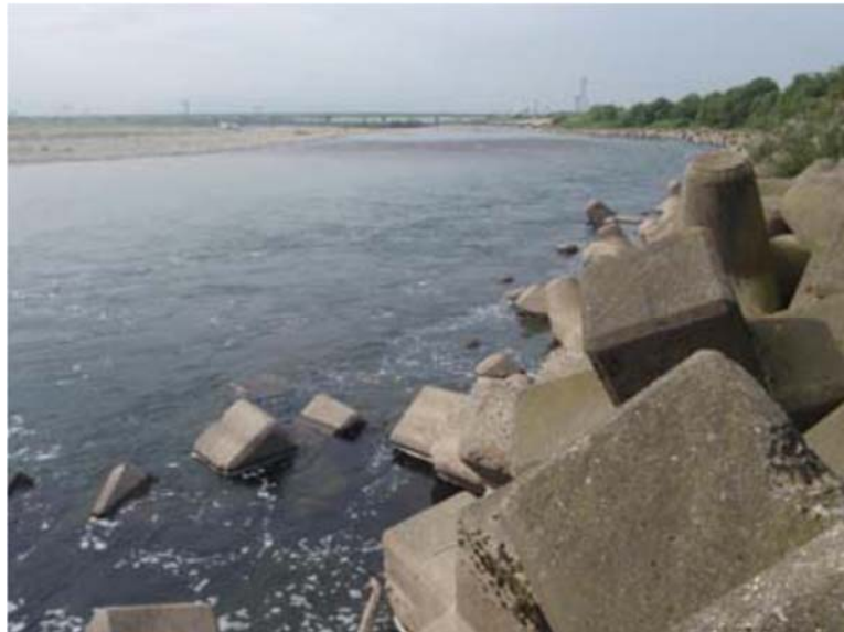
図-13 水衝部の淵のブロック（神通川）
