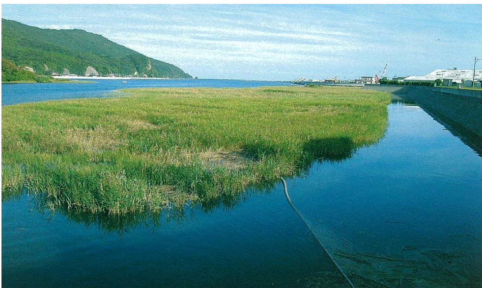
図-12 特殊堤を用いて河川環境へのダメージを最小限にした例（北川）
