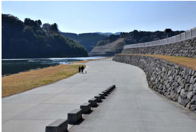
図-17 護岸を一枚のり面にせず、途中に小段を入れて水平方向に2段に分節している（川内川）
