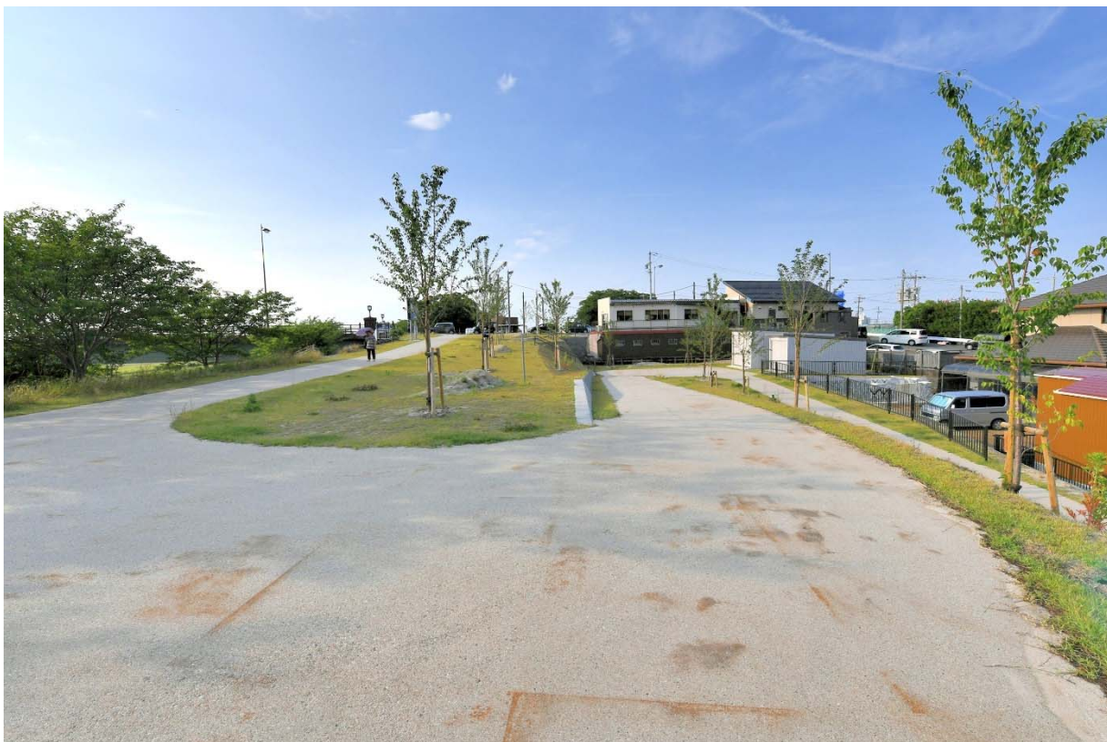
写真-7 度会橋上流水防広場付近
