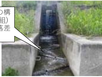
図一10 樋管の吐口部の改良
