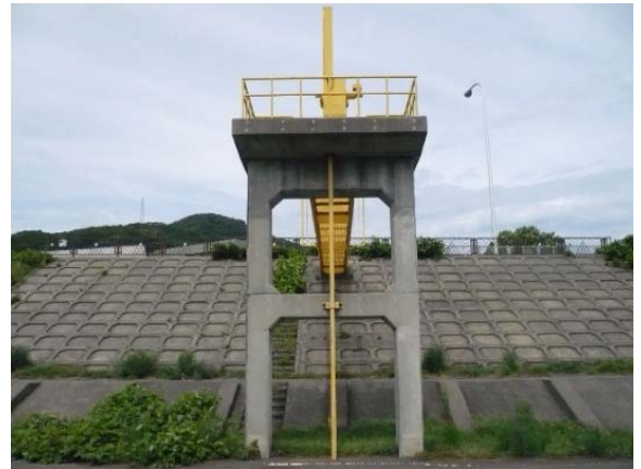
図-29 樋管の条件護岸などでも、景観や自然環境上果たすべき機能に配慮したい
