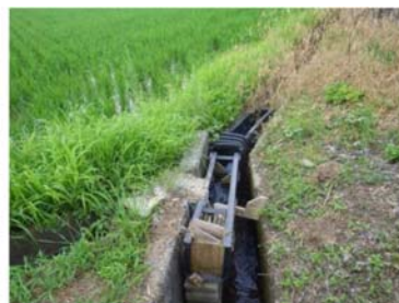
簡易魚道の設置
