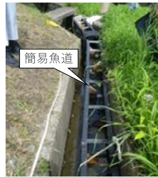
図一12 簡易魚道の設置
