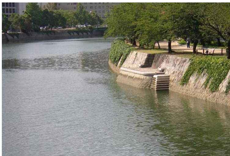
図-18 階段やテラスが流軸方向の連続性を分節し、単調な見えの連続に変化を与えている（太田川）
