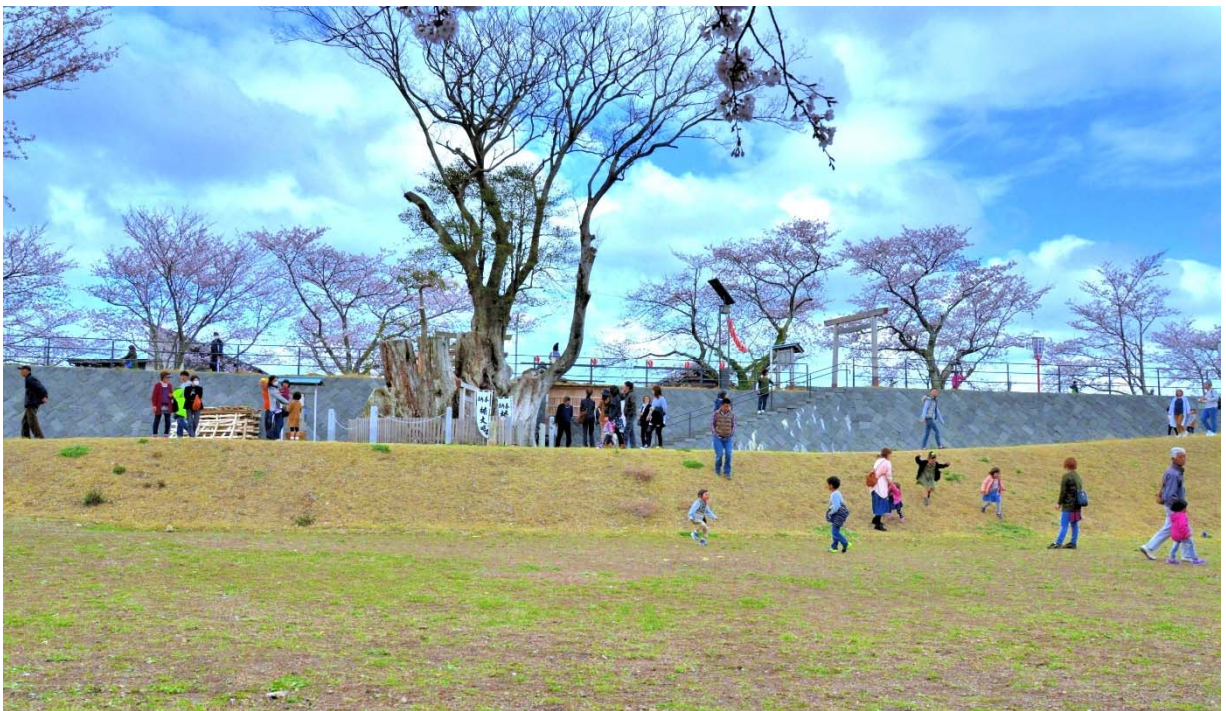
写真-6 境楠の保全。護岸を立てて現存する境楠を保全し、合わせてスロープと階段を設けて境楠や高水敷へのアクセスがしやすいように整備した。
