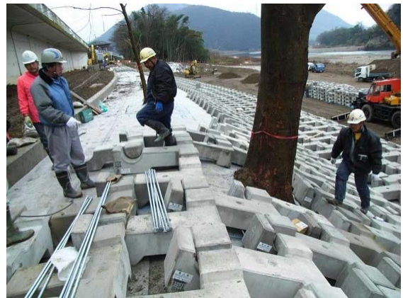
高木を避けてブロックを配置 高木の周囲はブロック同士を連結
