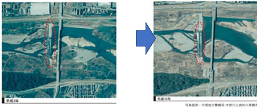
図-4 滯筋の変化の例 滯筋の変化により、床固工（円内）上下流の砂州形状が変動している。
