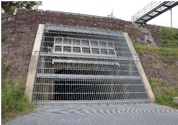
図-30 排水樋管の取り付け護岸に、石積み護岸を採用し、景観に配慮した事例（筑後川）
