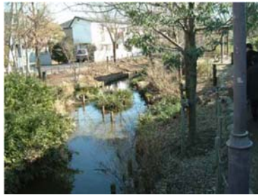
図ー7 コンクリート水路撤去の事例 4)
