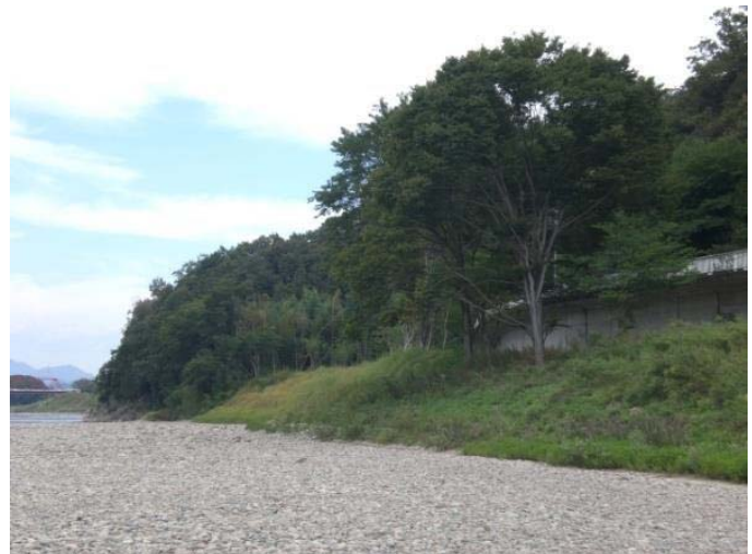
図-15 高木を避けてブロックを配置（写真右上）し河畔林を保全 施工直後（写真左）と施工後6ヶ月後の状況（写真右）
