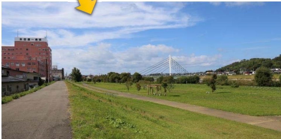
写真-12 改修前後の様子（上：改修前 11) 、下：改修後）
