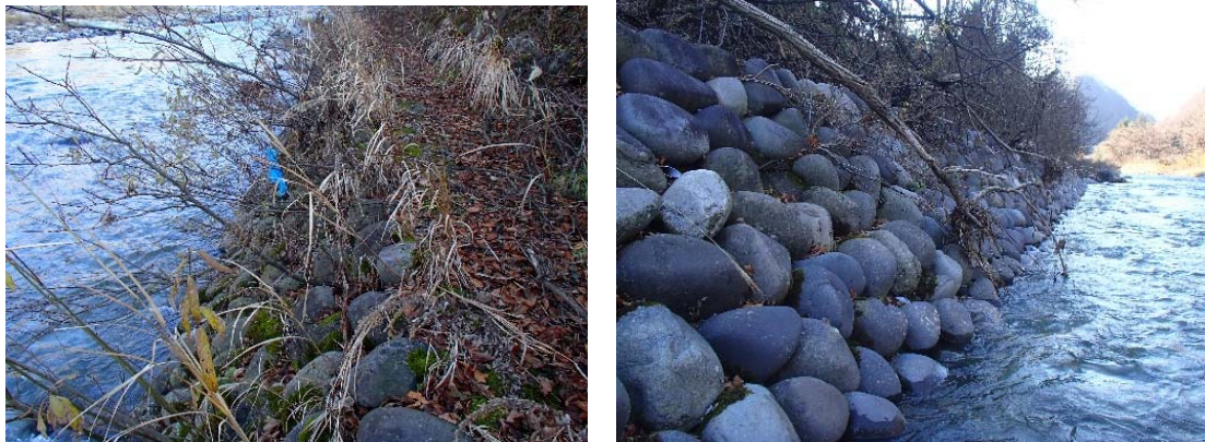
図-27 玉石（練積み）護岸の裏込材に、ポーラスコンクリート（左）と普通コンクリート（右）を用いた場合の差異
