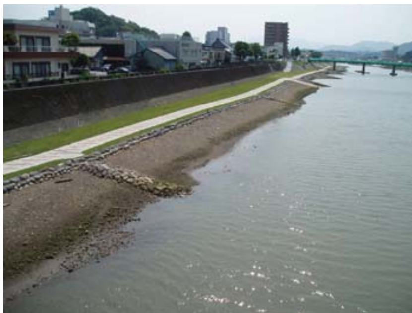
図-4 潮間帯として整備した緩傾斜河岸の状況（五ヶ瀬川）
