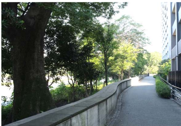
写真-10 堤防法線をカーブさせて木を保存(右岸) 11)
