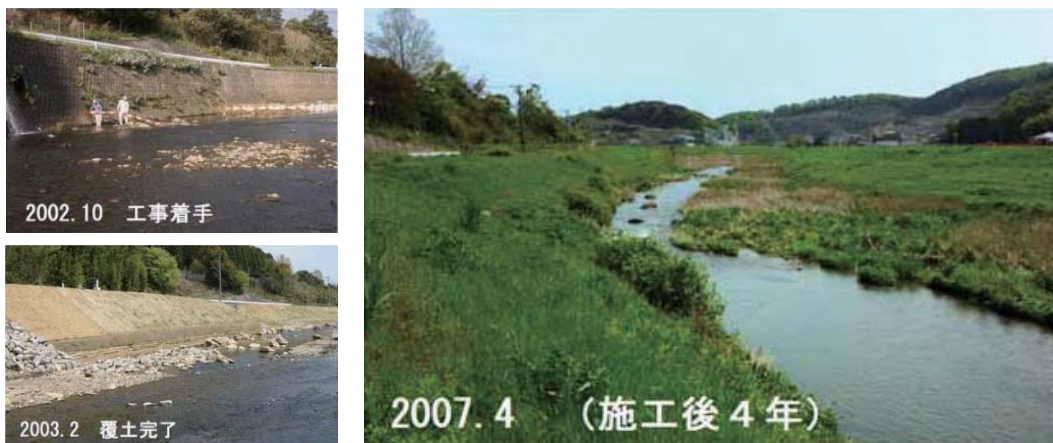
図-9 覆土による自然な河岸の形成(牛津川)
