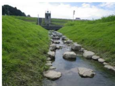
多自然水路への改築
