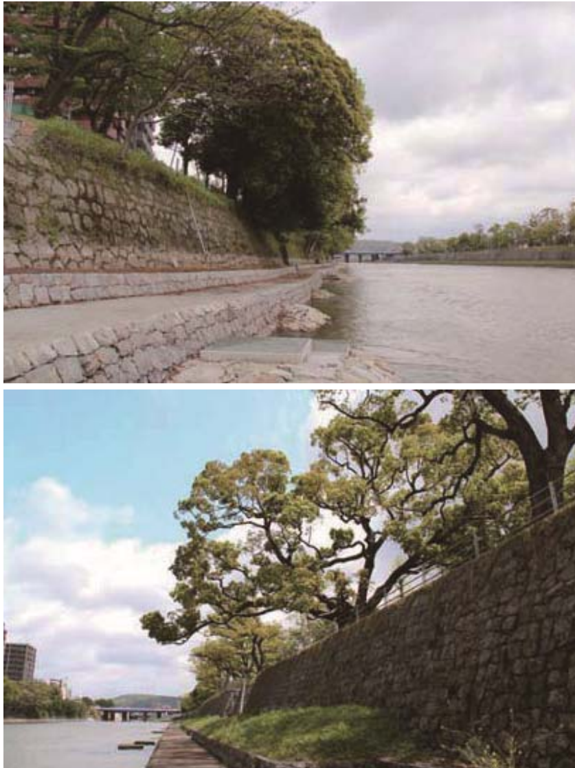
図-10 右岸側で保全した石積み護岸（上）と、左岸側で整備した石積み護岸（下）（白川）
