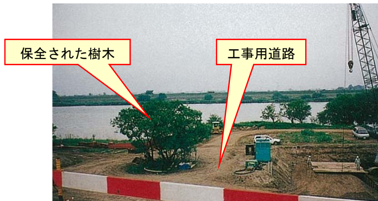
図-32 周辺の植生に配慮して工事用道路等を設置した例（長良川） 17)
