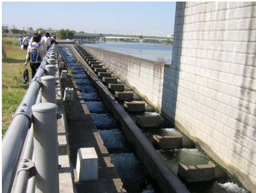
図-9 改築後の二ヶ領宿河原堰 上：堰全景 下：魚道 (多摩川)
