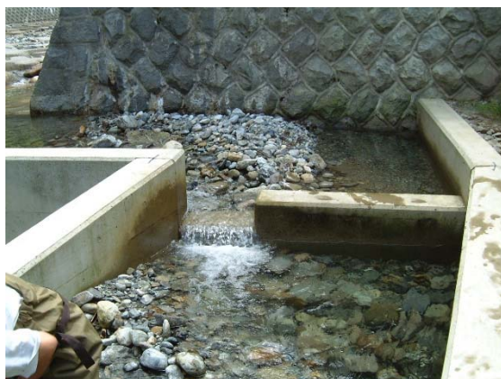
図-5 魚道に流入した土砂
