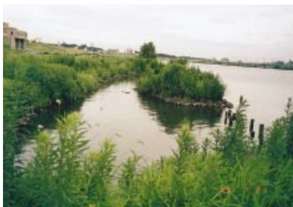
写真 - 4 本川低水路河岸に整備したワンド（完成後1年半）
