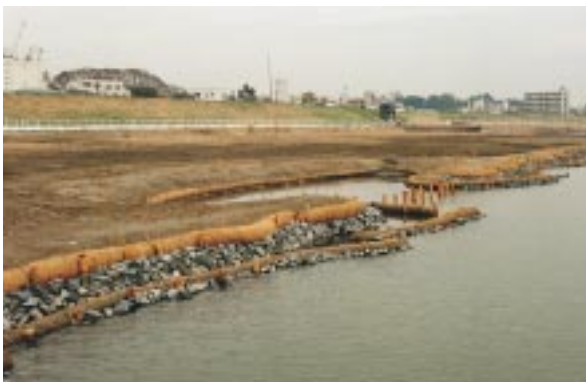
写真 - 3 本川低水路河岸に整備したワンド（完成直後）
