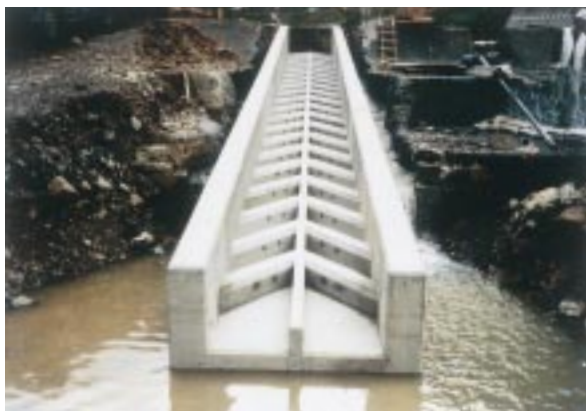
写真 - 4 舟通し型魚道 (施工中)
