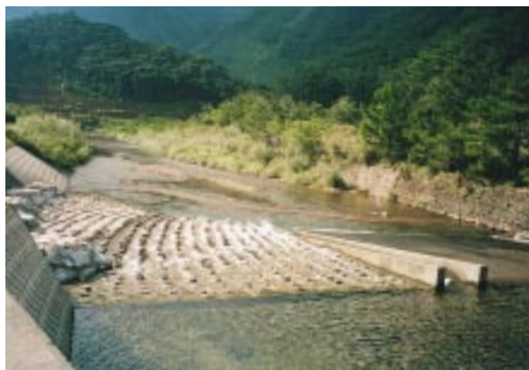
写真 - 6 上流から見た斜曲面型魚道
