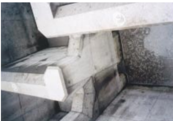
写真 - 3 アイスハーバー型魚道 (施工中)
