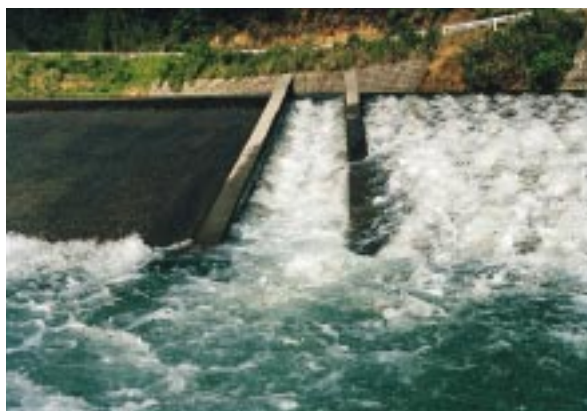
写真 - 5 下流から見た舟通し型魚道と斜局面型魚道
