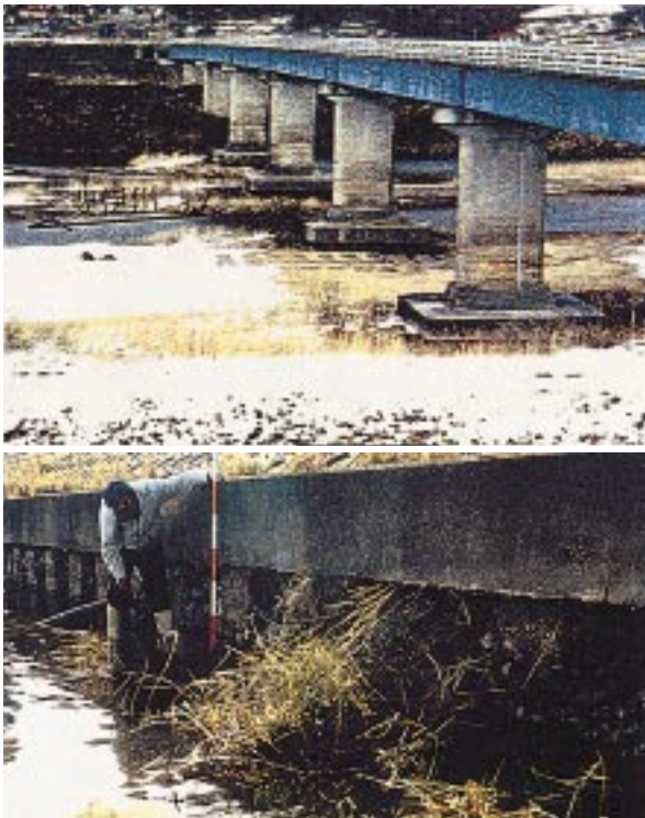
図 - 2 河床低下による構造物の浮き上がり
