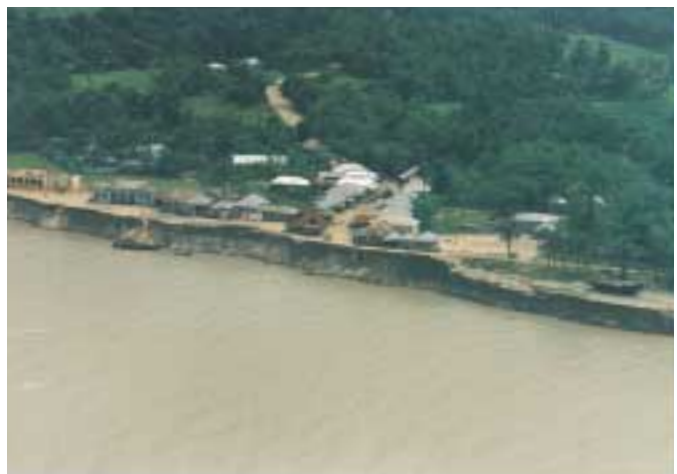
写真 - 2 ガンジス川本川左岸側の川岸欠壊状況
