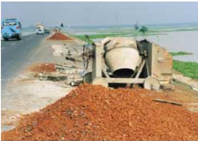
写真 - 1 護岸用ブロックの骨材に使用する破碎レンガ
