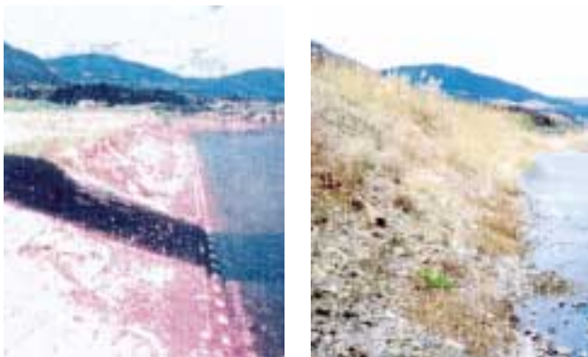
洪水により流出した覆土（左図）が数年後には回復（右図）
