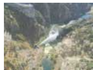
写真 - 3 同ダムの放水状況（20km下流が国境）
