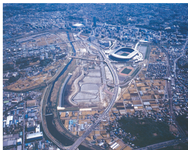
写真－1 工事中の鶴見川多目的遊水地
