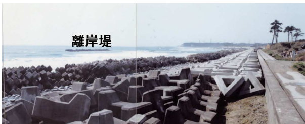
写真-3 高潮対策により設置された離岸堤
