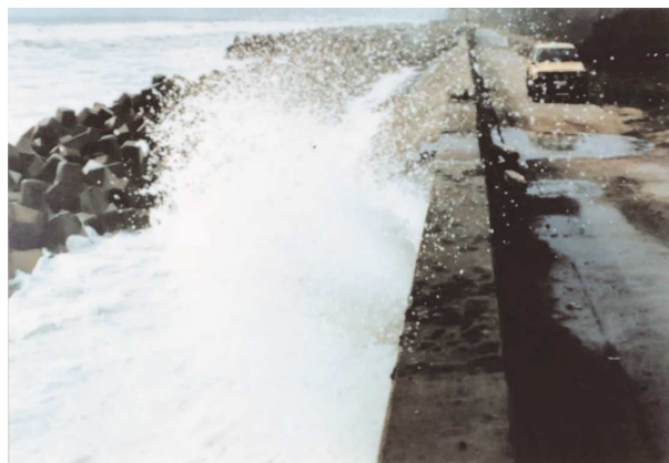
写真-4 整備前の越波状況
