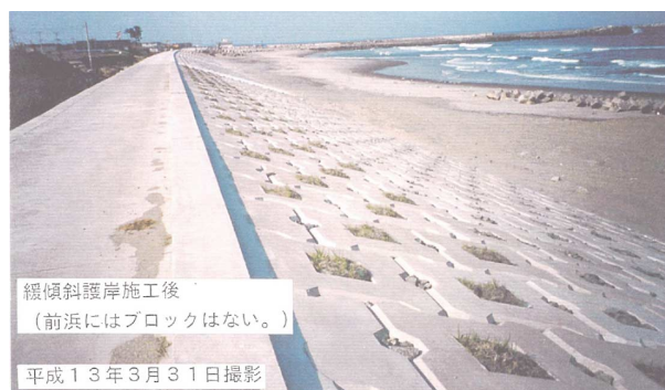
写真－6 整備後の状況（平成13年3月）
