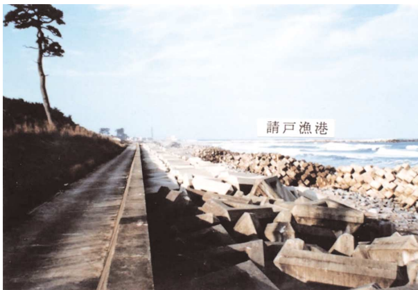
写真-2 整備前の状況
