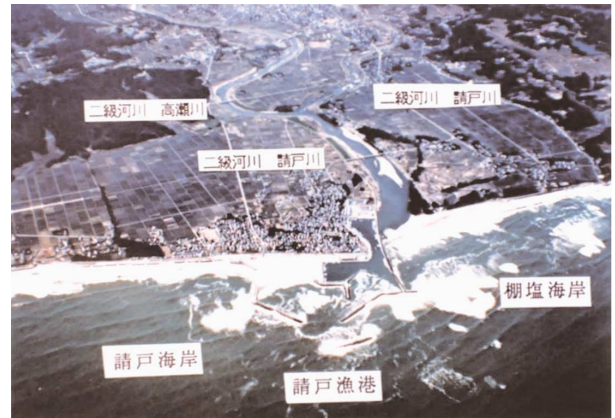
写真-1 請戸海岸周辺状況
