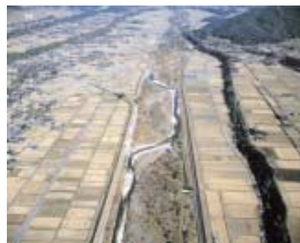
現在の三峰川の状況（下が下流側）
