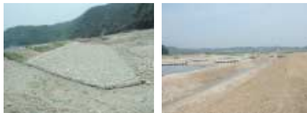
蛇籠護岸+覆土で環境、景観に配慮
