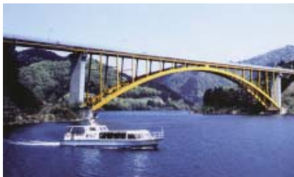
写真－1 神奈川県宮ヶ瀬ダム 虹の大橋
