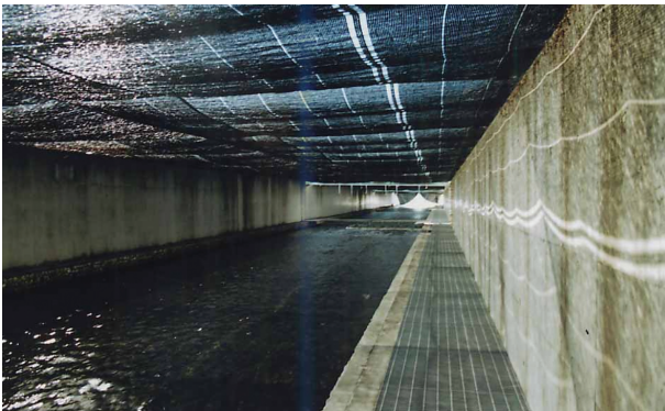
写真-10 産卵床として機能確認を行った左岸人工河川式魚道 ※産卵床上部には鳥類等の外敵から親魚及び卵を保護するとともに、卵に有害な紫外線の影響を軽減させるため防鳥ネット（寒冷紗（カンレイシヤ））を設置
