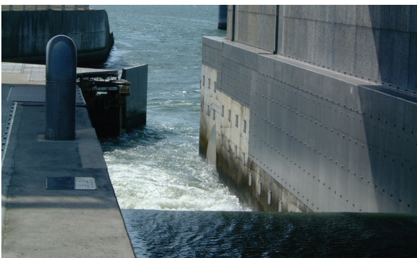
写真-11 左岸呼び水水路
