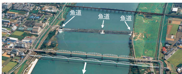
写真-3 新六ヶ井堰の状況
