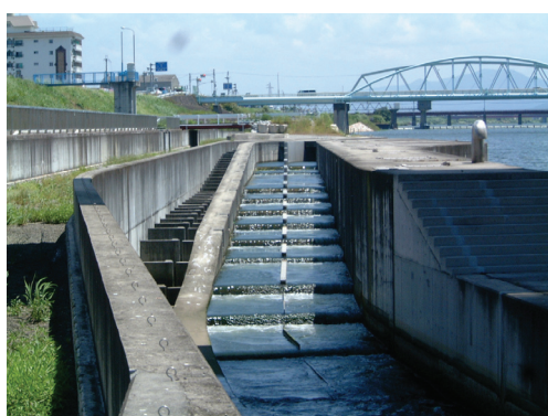
写真-8 隔壁を上下にスライドする機能を付加した右岸階段式魚道 また、左岸側魚道では右岸側魚道で実施した遡上実験結果をもとに、可動隔壁間のプール水深を常に一定に保つよう可動隔壁駆動に追従するプール底部
