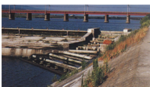
写真-4 濁水時の新六ヶ井堰の魚道
