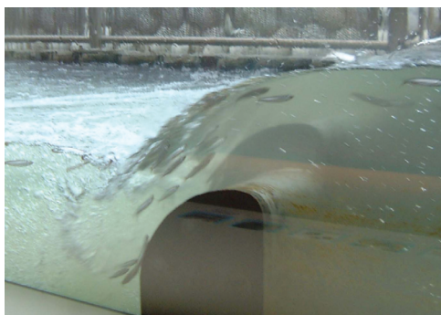
写真-9 アユの遡上が始まった左岸階段式魚道(平成16年3月25日撮影)
