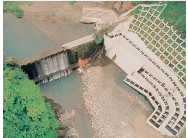
写真－2 倉見砂防堰堤魚道
