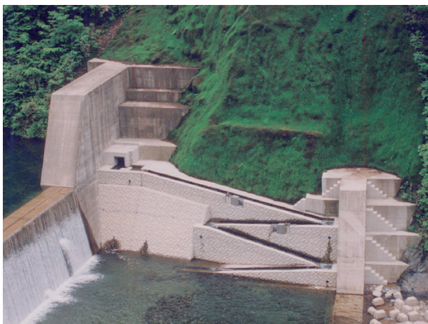
写真－1 根尾西谷川砂防堰堤魚道
