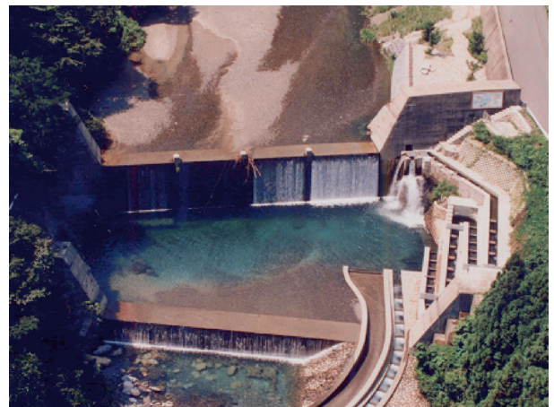
写真－3 坂内砂防堰堤魚道
