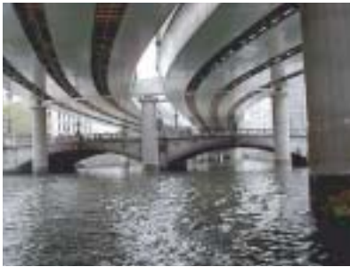
写真－５ 日本橋の上を通過する都市高速道路（東京都中央区）
