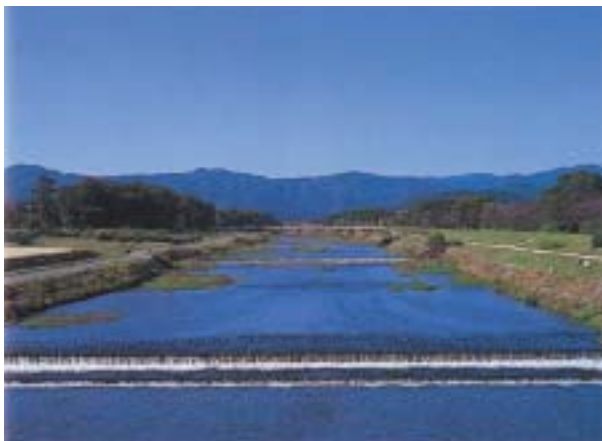
写真－6 北山大橋より上流を望む
