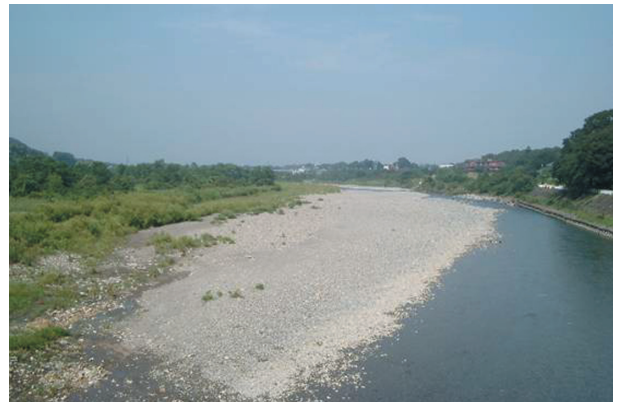
写真—1 河道修復後の様子
