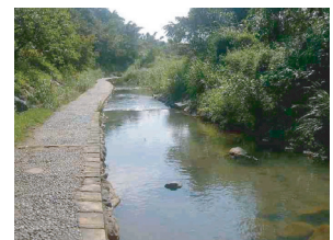
写真-4 ビオトープ護岸
