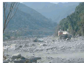
写真-3 土砂堆積状況
