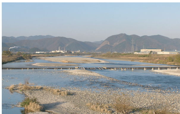
根尾川第一床固工全景（下流より写す）
