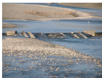
魚道詳細写真
