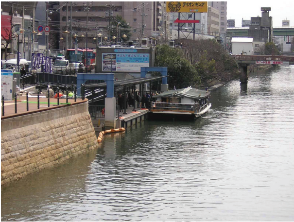
写真－5 納屋橋船着場
