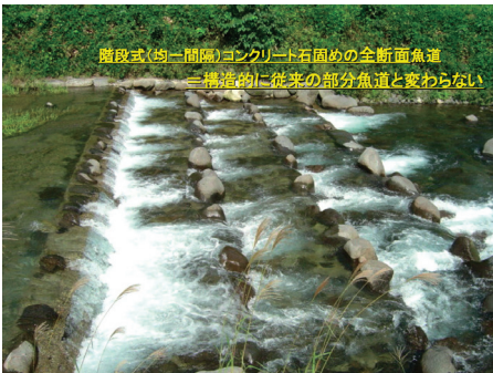
階段式の全断面魚道 (岐阜県長良川水系)
