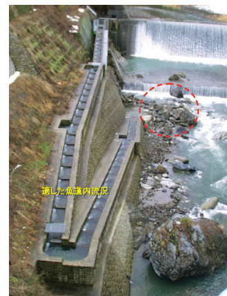
魚道下流口の土砂堆積 (赤破線の円) (岐阜県揖斐川水系)
