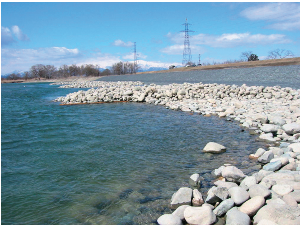
高久護岸災害復旧工事のカゴマットと捨て石
