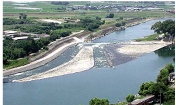
山田堰 筑後川中流部にある斜堰は、全国的にも少なくなった江戸期の取水堰の形を良く残している
