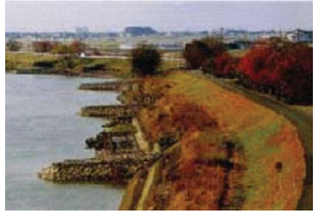
菊池川とハゼ並木 河川堤防強化のために植えられたハゼ並木と堤防を守る石積み水制がつくり出す文化的な景観
