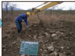
試験箇所への覆土・整正
