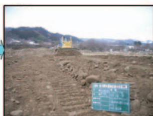
ブルドーザによる下層の掘削押土
