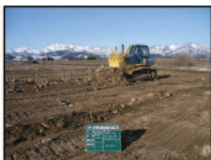
ブルドーザによる表層の掘削押土
