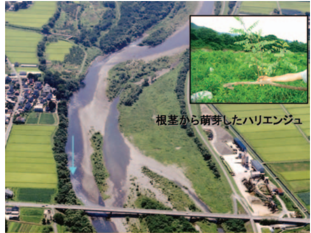
写真-5 伐採・抜根後のA地区
