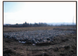
作業完了(覆土25cm)
