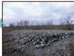
作業完了(覆土50cm)
