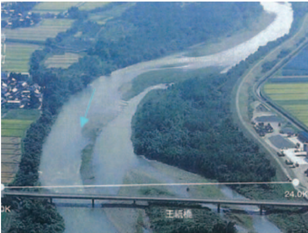
写真-4 伐採・抜根前のA地区
