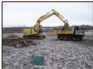
覆土材料の積込・運搬
