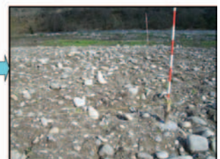
作業完了(写真は掘削深0.4m部)
