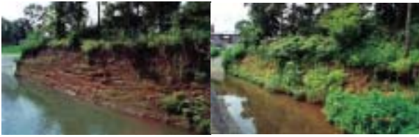
写真-3 切土にして放置した法面
