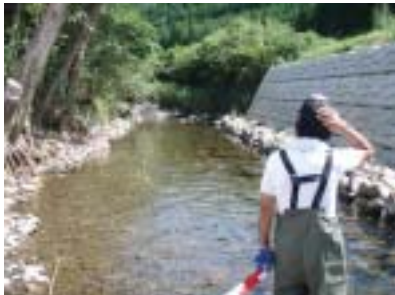
写真-4 景観への配慮は護岸工法のベースとなる。水際の生息空間保全のため石礫を投入した例。それ自体は評価できるが法面のデザインに課題が残る。
