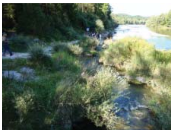
図-5 一見すると魚道とわからない緩勾配水路式の魚道
