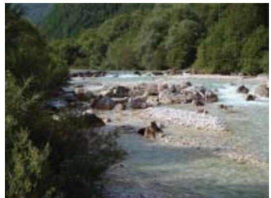
図-3 コンクリートの落差工をいくつか分割して、一基あたりの落差を小さくし、巨石を用いた自然な落差工としている「ランプ工」
