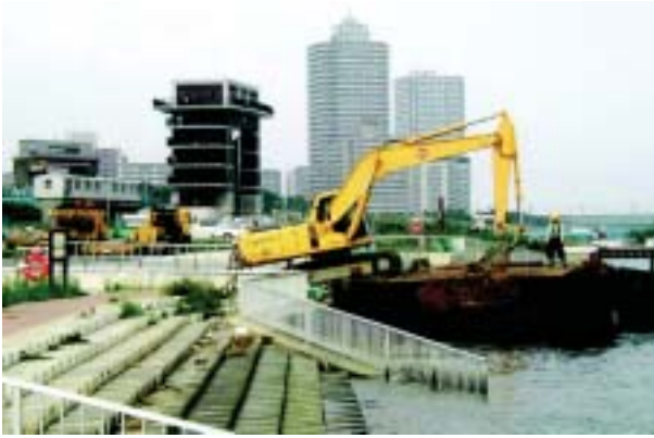
岸壁型RSでの重建設機械搬入状況
