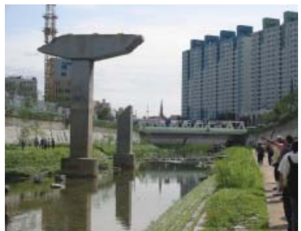
図-5 清溪川、記念として残されている高架道路の橋脚、2005年9月筆者撮影
