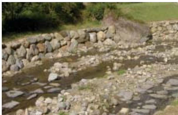
図-2 大転石の活用(山附川,平成17年台風14号被災復旧)(宮崎県資料)
