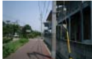
写真-6 沿線に存在するブロック塀・電柱
