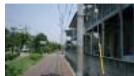
写真-11 壁面の位置の制限前の現在の状況
