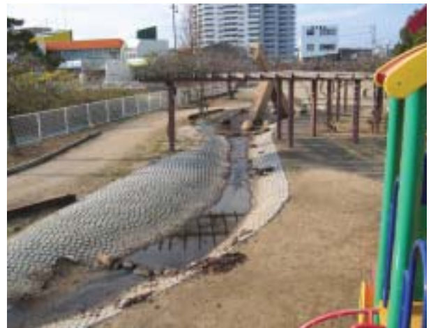
写真-2 整備前の平山公園 —動植物が棲める環境ではない—
