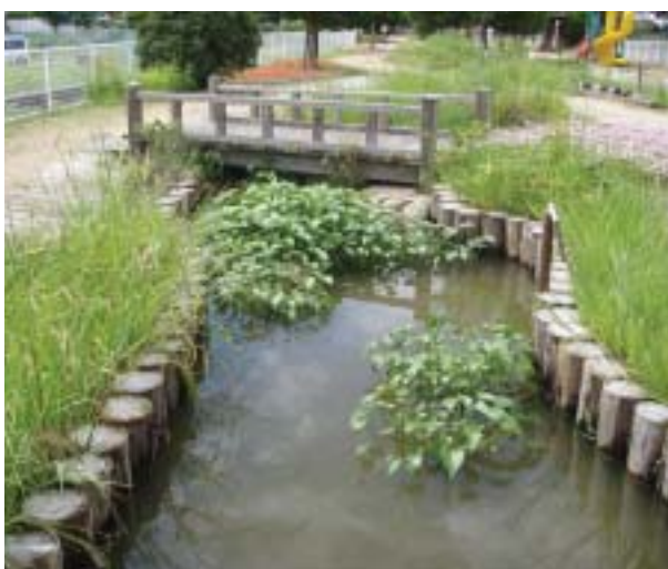
写真-4 ビオトープ下流 —木柵による護岸—
