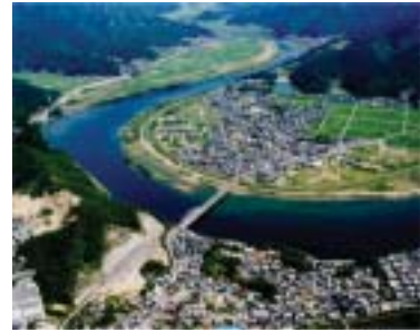
図-5 北川における河川敷掘削箇所
