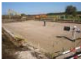
写真-4 Spfa 1,2 層置換直後の浸透施設
