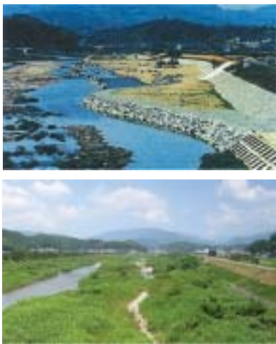
図3 整備後13年が経過した魚の避難場所 (上：1997年施工時、下：2010年8月現在) 「JRRN Newsletter Volume 39」より引用
