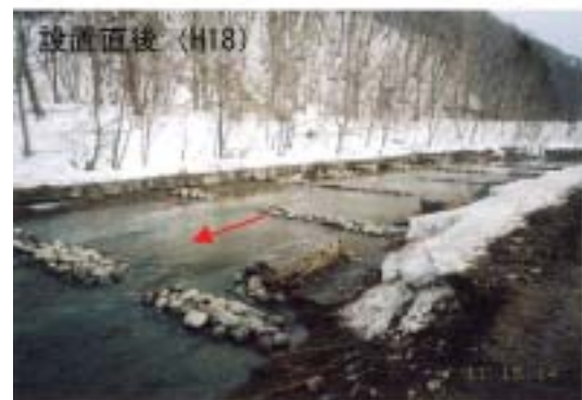
写-3 実験施設（設置前と設置直後）
