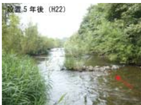
写-5 実験施設（施工5年後）
