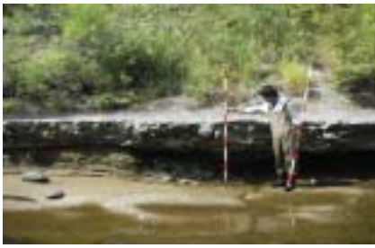
写真-1 岩盤河床の現状
