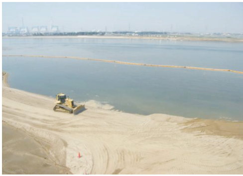
写真-3 干潟造成（施工時）の状況
