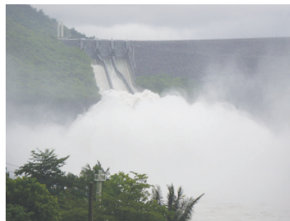
写真2 出水後の曾文ダム
