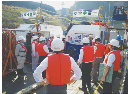
写真8 鶴田ダム飽和潜水工法の見学
