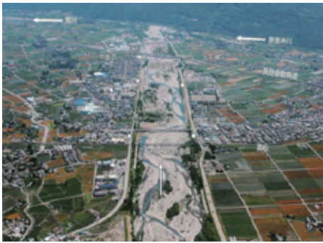
写真-3 多列砂州の事例 (梓川下流部)
