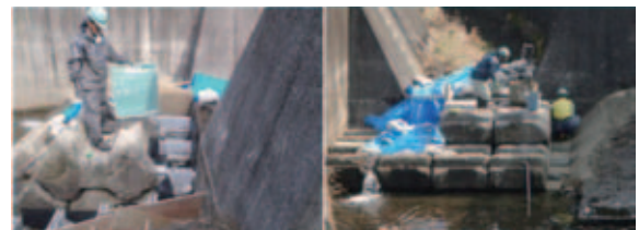
簡易魚道の土台部分の工事
