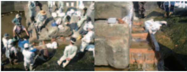
魚道の隔壁を仮設置して検討
