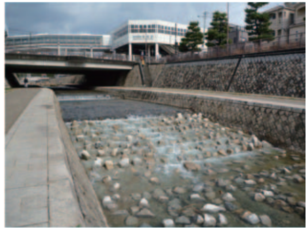
図4 小わざ魚道 (全面型方形配置、神戸市住吉川)
