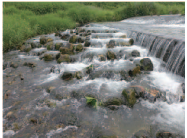
図1 水辺の小わざ魚道(中央設置型、岩国市島田川)
