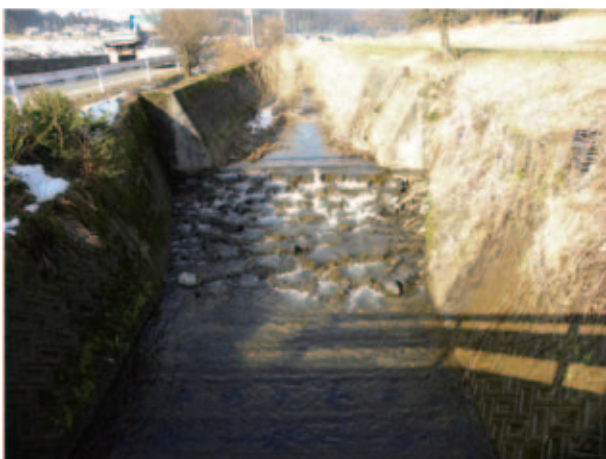
図3 小わざ魚道 (全面型ウロコ配置、越前市丸岡川)
