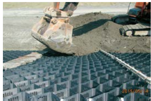
図8 ハニカムフレームにC型クランプを採用
