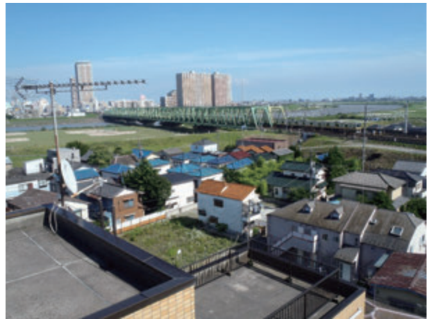
着手前北小岩地区（撮影土屋）
