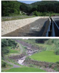
直線で河道を復旧した事例(上)と蛇行を活かして復旧した事例(下)
