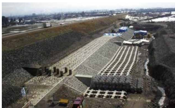
図-2 常願寺川の護岸工(根継護岸工)
