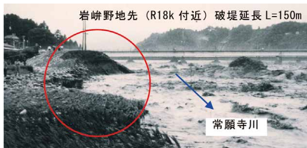
図-1 昭和44年8月洪水時の侵食破堤状況
