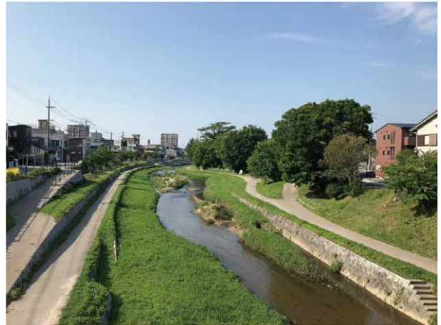
平成30年6月（施工後7年）の様子
