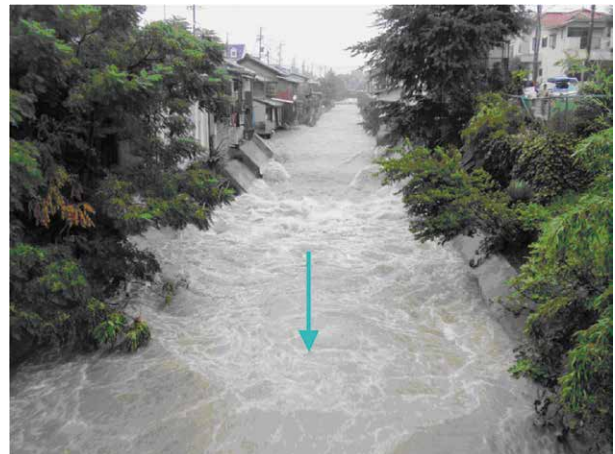
瀧見橋上流の出水状況
