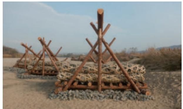
写真5 中聖牛による試験施工の実施状況(木津川)
