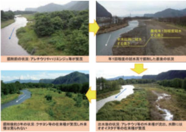
写真2 実施箇所の変遷 (千曲川)
