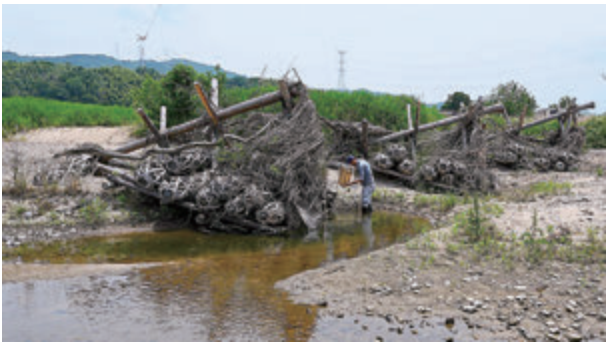
図4. 2018年に設置した第2聖牛群は2019年の増水で棟木が折れて変形した。
