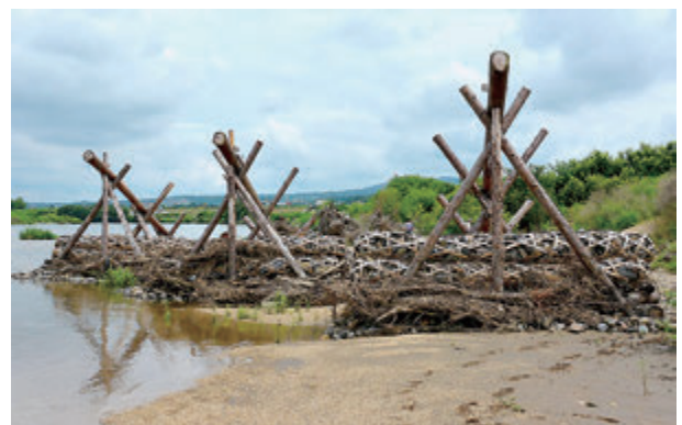
図3. 2018年に設置して1年後の第2中聖牛群(手前)、下流奥手は2017年に設置した第1中聖牛群。
