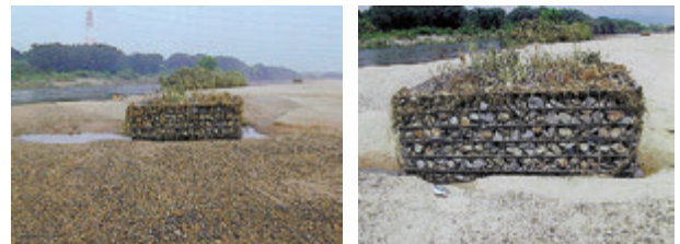
図2. 初期の河川生態学術研究会木津川研究グループが行った人工たまり実験。1999年にたまりを掘削し、洗掘促すための布団籠を設置したが、1年後には土砂堆積でたまりは消滅した。
