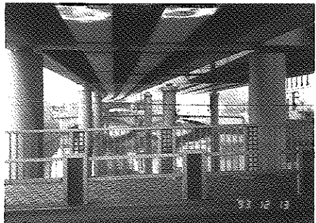
写真-6 日本橋川 (西岸橋から日本橋方向)
