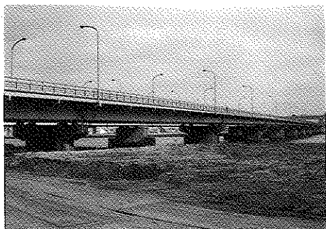
写真－2 小松川橋
